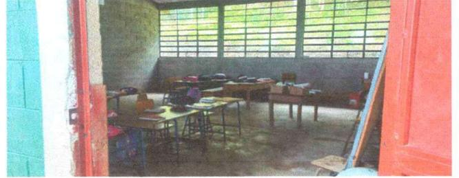
Foto 2: Interior del aula, donde se muestra deterioro del suelo, donde se colocará piso cerámico.
