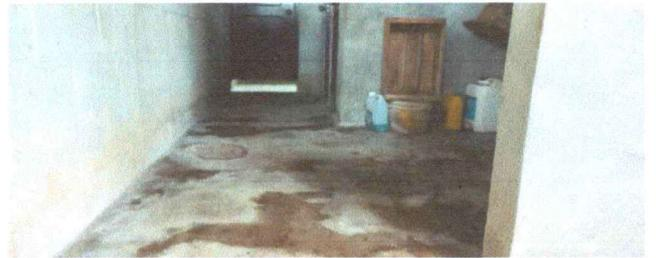
Foto 6: Interior del baño, donde se muestra deterioro del suelo, donde se colocará piso cerámico.
