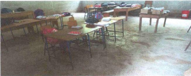
Foto 3: Interior del aula, donde se muestra deterioro del suelo, donde se colocará piso cerámico.
