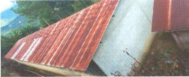
Foto 1: Cambio de techo por el óxido de las láminas y goteras en las mismas.
